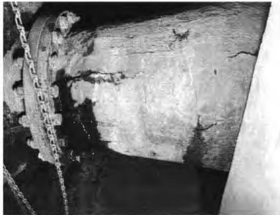
**Figura 1. Vista inicial de rotura en tubería**
